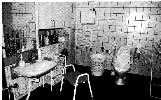
写真3. シャワー室には洗濯乾燥機も設置
